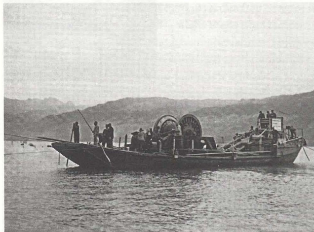
2 Zürichsee: Verlegung der SBB-Kabel für die Strecke Rapperswil – Winterthur.
